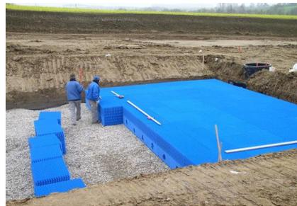
Bau einer Füllkörperrigole (Foto: Sieker)
