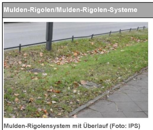
Abb. 16: Beispiel für Mulden-Rigolensystem, aus [6]
