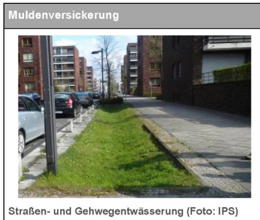
Abb. 15: Beispiel zur Muldenversickerung, aus [6]
