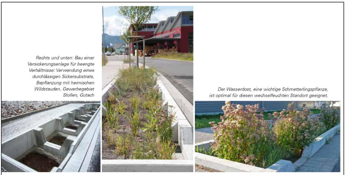
Rechts und unten: Bau einer Versickerungsanlage für beengte Verhältnisse: Verwendung eines durchlässigen Sickersubstrats, Bepflanzung mit heimischen Wildstauden. Gewerbegebiet Stollen, Gutach
