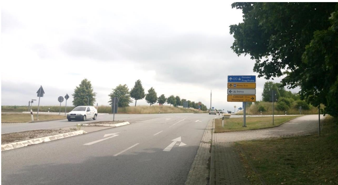
Foto: Knotenpunkt S 178A/ Reppchenstraße/ Köttewitz, Blickrichtung Autobahn (Stand 2018)
