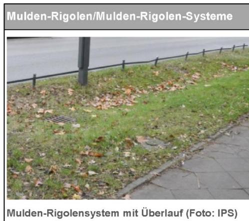
Abb. 18: Beispiel für Mulden-Rigolensystem, aus KURAS-Leitfaden
