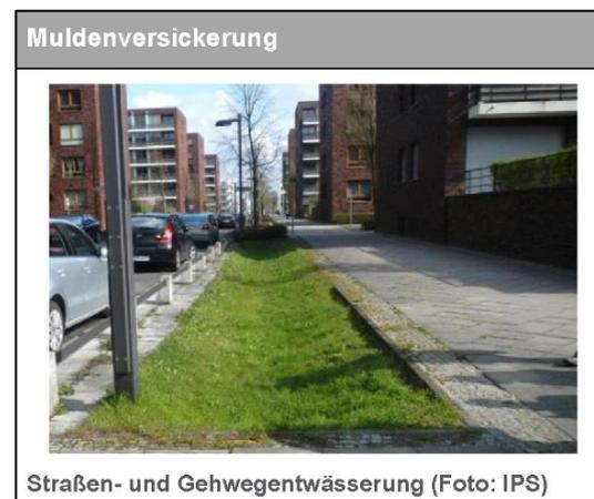
Abb. 17: Beispiel zur Muldenversickerung, aus KURAS-Leitfaden
