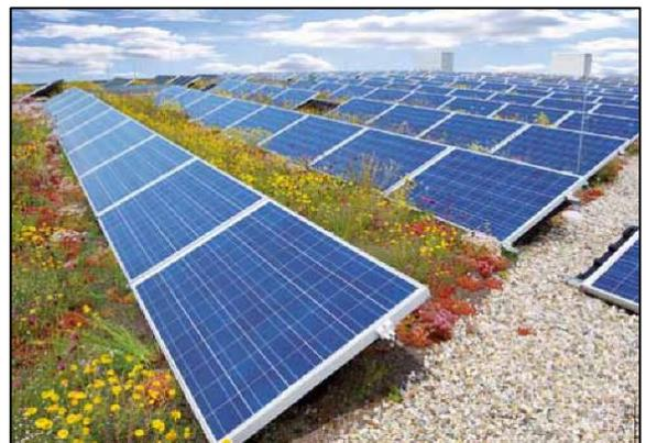
Abb. 25: Beispiel für Dachbegrünung mit Photovoltaik-elementen, aus Landesanstalt für Umwelt, Messungen und Naturschutz, Baden-Württemberg 2015
