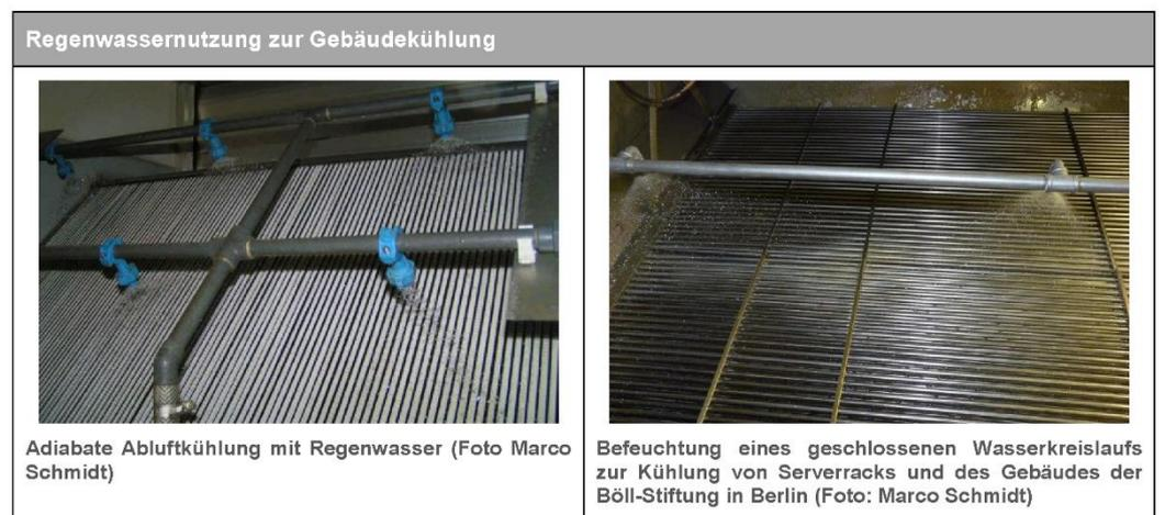
Abb. 29: Beispiele für Kühlungsverfahren mit Regenwasser, aus KURAS-Leitfaden
