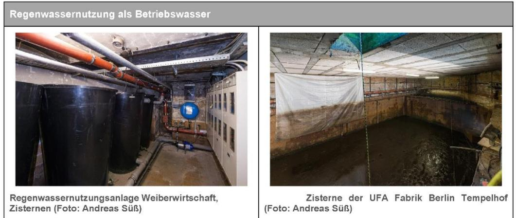
Abb. 28: Beispiele für Regenwassernutzung als Betriebswasser aus KURAS-Leitfaden
