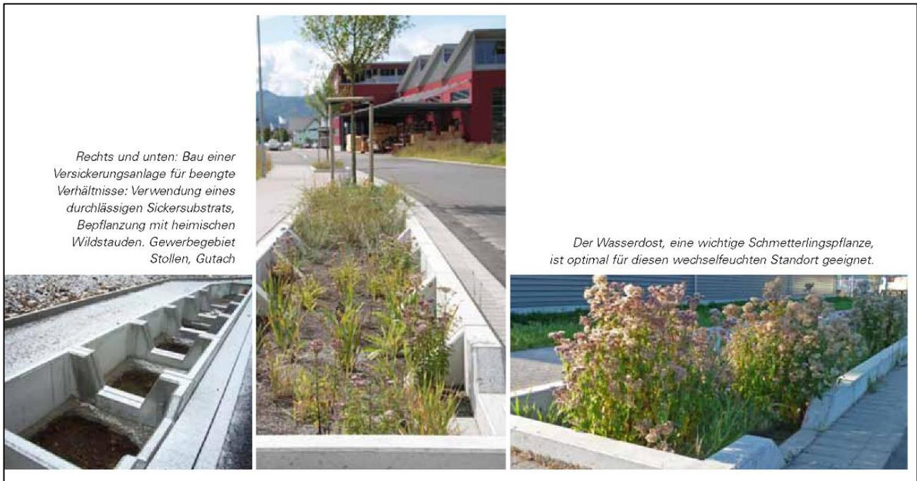
Abb. 22: Beispiele für Sickerkästen aus Betonfertigteilen, aus Landesanstalt für Umwelt, Messungen und Naturschutz, Baden-Württemberg 2015
